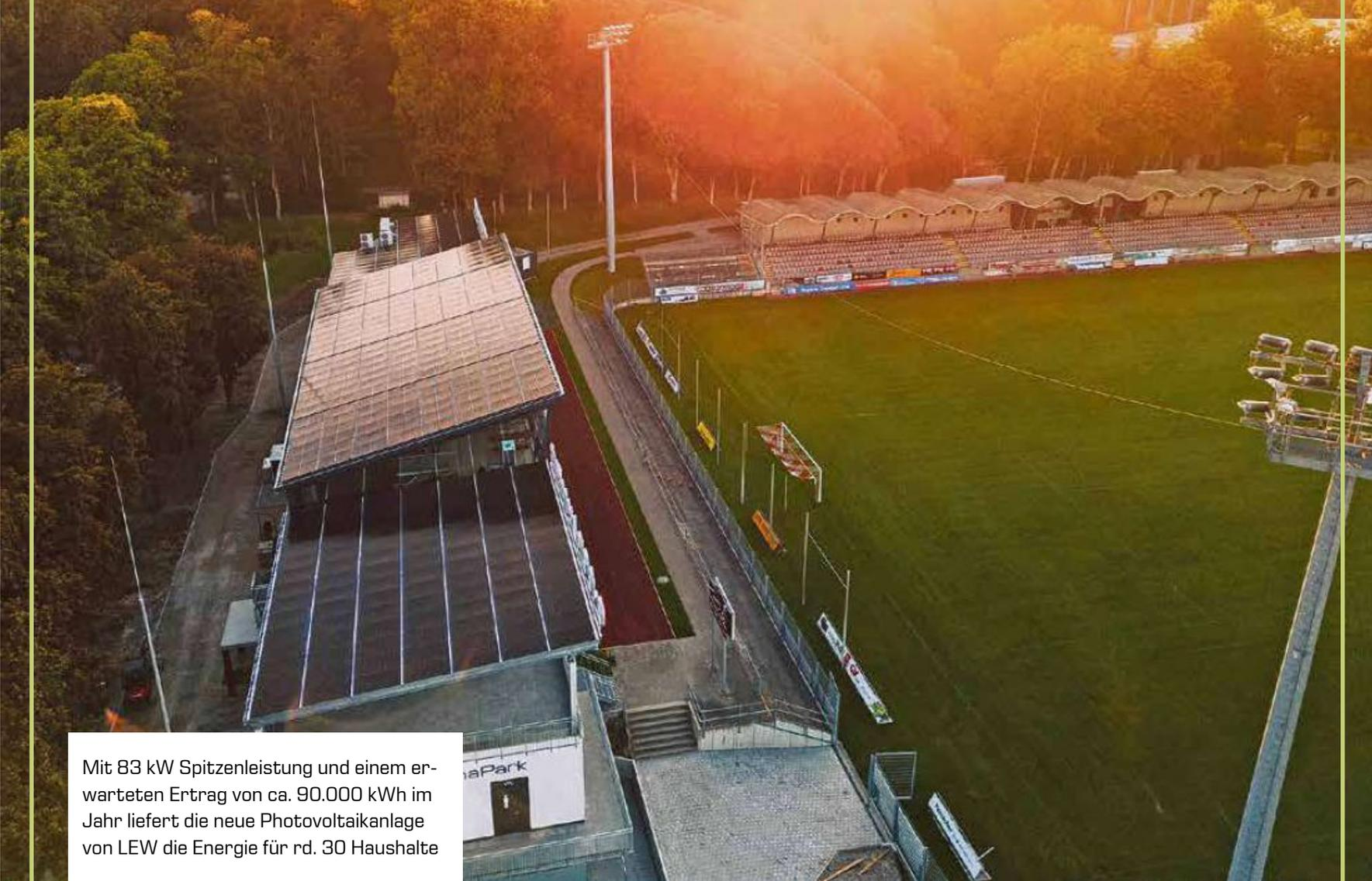
Mit 83 kW Spitzenleistung und einem erwarteten Ertrag von ca. 90.000 kWh im Jahr liefert die neue Photovoltaikanlage von LEW die Energie für rd. 30 Haushalte
